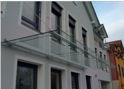
breite Überdachung mit Gläsern auf Stoß
