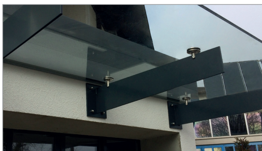
beschichtete Schwerter passend zur Haustür
